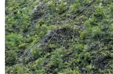
特殊金網(厚ネット)を法面に密着させ、斜面に点在する浮石・転石の初期始動を予防して現位置にて押え込む、発生源対策工です。土砂部の浸食を少なくすると共に、法面の安定および緑化促進にも優れています。
