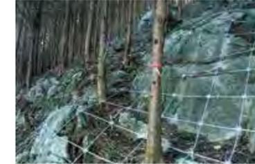
ワイヤロープを格子状に組み、斜面に点在する浮石・転石の初期始動を予防して現位置にて押え込む、発生源対策工です。立木の伐採を最小限に、自然の美観を損なうことなく施工が可能です。
