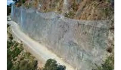
ワイヤロープと金網で構成されたネット部で落石エネルギーを吸収します。弾性限度内の許容耐力で設計しているため、繰り返し落石を受けることが可能な高エネルギー吸収防護工です。
