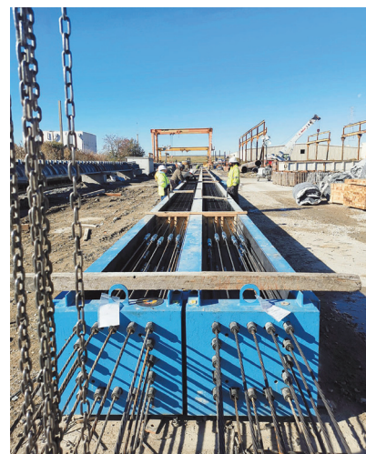
④ハーカース・アイランド・ブリッジプロジェクトの2つの橋梁(現橋、⑤パイルの製作現場と炭素繊維複合材ケーブル(CFCC®))
