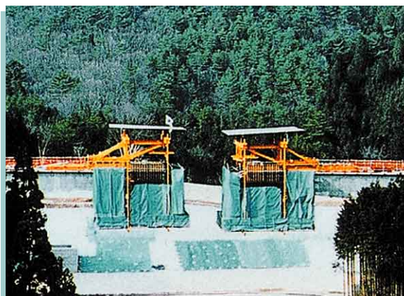
PC桁の張出し状況
