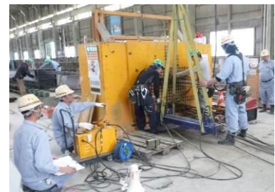
写真-2 PC ホロー桁製作状況
