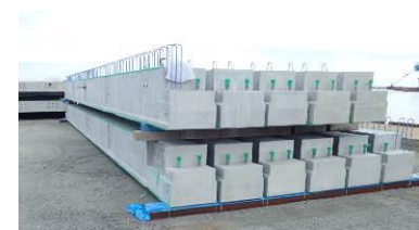
写真-3 PC ホロー桁仮置状況
