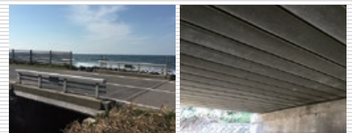
現橋: CFCCを使用したPC橋 [建設後29年経過]
