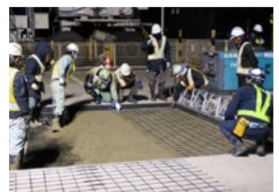
CFCC補強筋: 名古屋港飛島ふ頭
