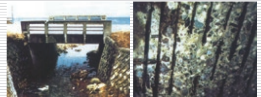
旧橋: 鉄筋を使用したRC橋 [建設後20年経過]
