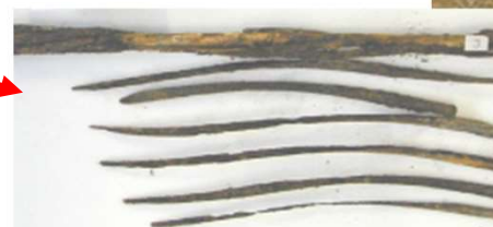
PC 鋼より線は、腐食が激しい
