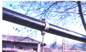
ポリエリレンチューブで 保護されたCFCCケーブル
