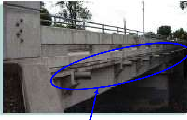
横締めケーブル (Transverse Post-Tension)
