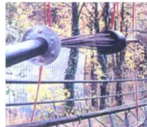
CFCCケーブルの設置
