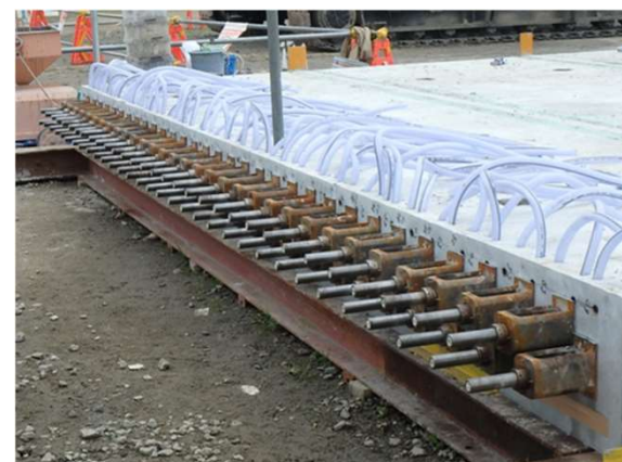
プレキャストPC版の連結 (ポストテンション緊張グラウト定着: 定着金具切断除去)
