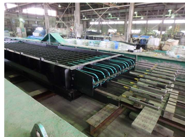
プレキャストPC版(プレテンション方式緊張中)
