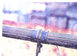
掛替え前の鋼製 ケーブル
