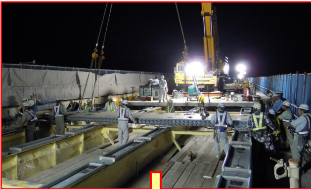
PCa 床版架設
