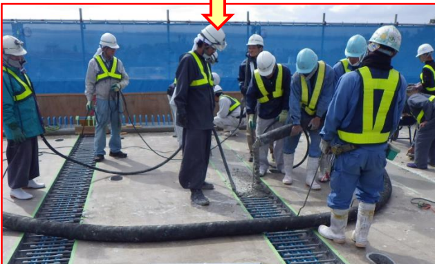
間詰部コンクリート打設
