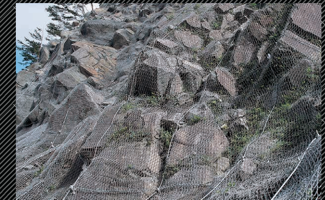
The thick net fixes the unstable stones of the slope Массивная сетка фиксирует неустойчивые камни на горном откосе
